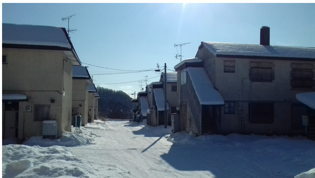
図7.夕張市清水沢の旧炭鉱労働者住宅
